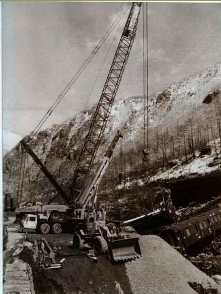
**Une grue capable de soulever une locomotive et la gare auxiliaire qui a servi à son montage.**
